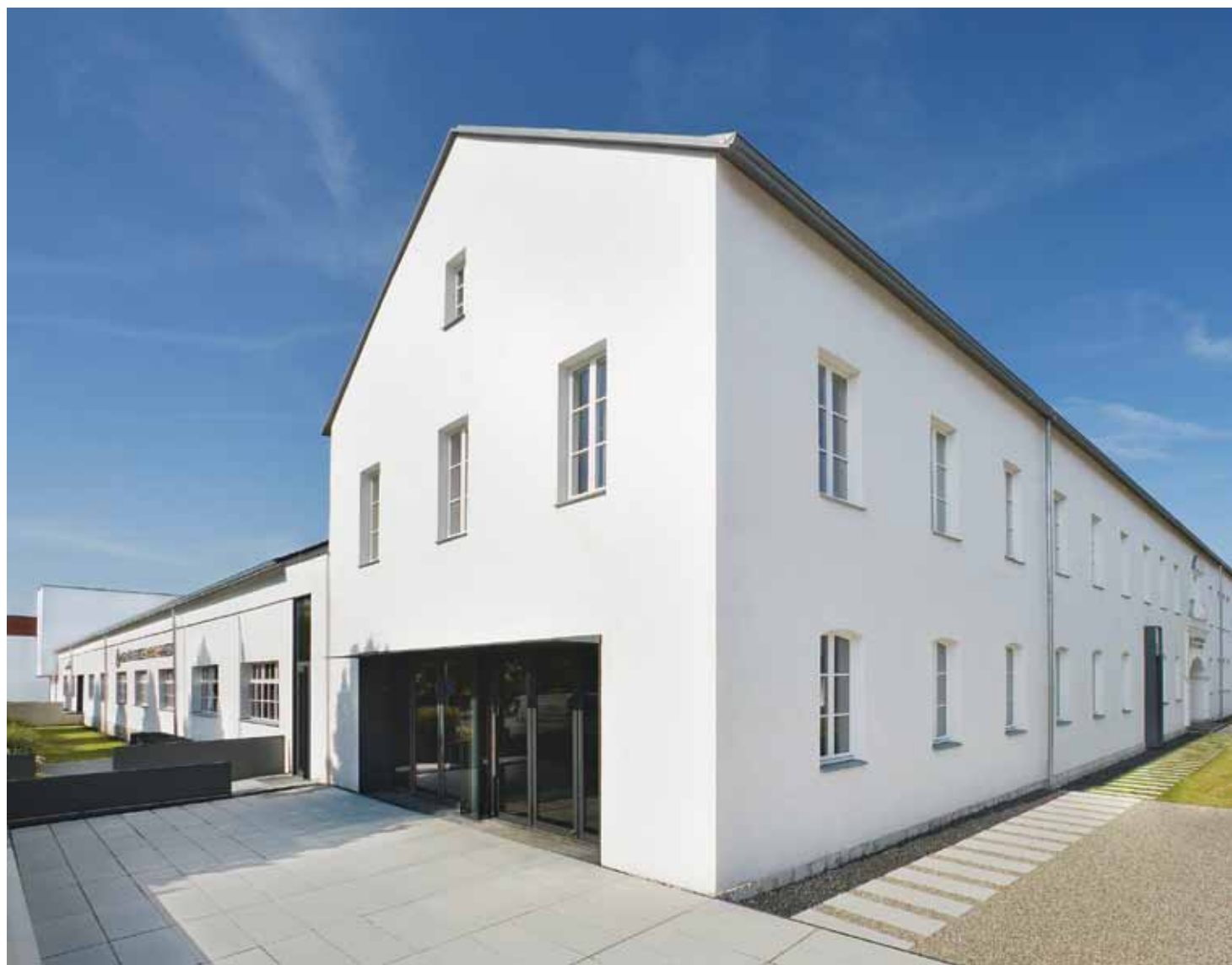
▲ Die XXL-Platten wurden im Kreuzfugenverband verlegt.
